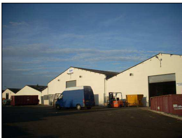
Façade Bâtiment coté quai
